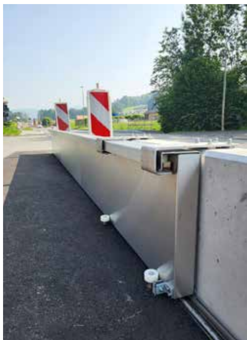
Dispositif anti-crue coulissant, en inox
