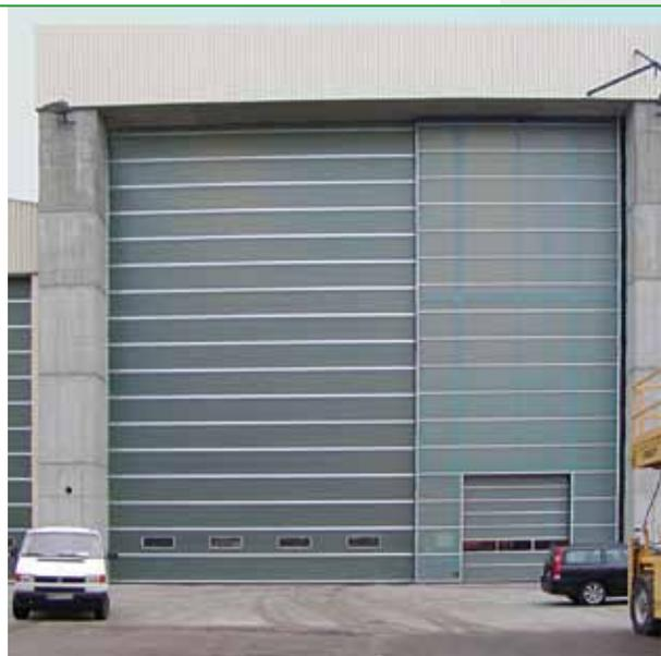
La porte dans la porte a pour vocation de permettre un passage rapide de véhicules de plus petite taille.
