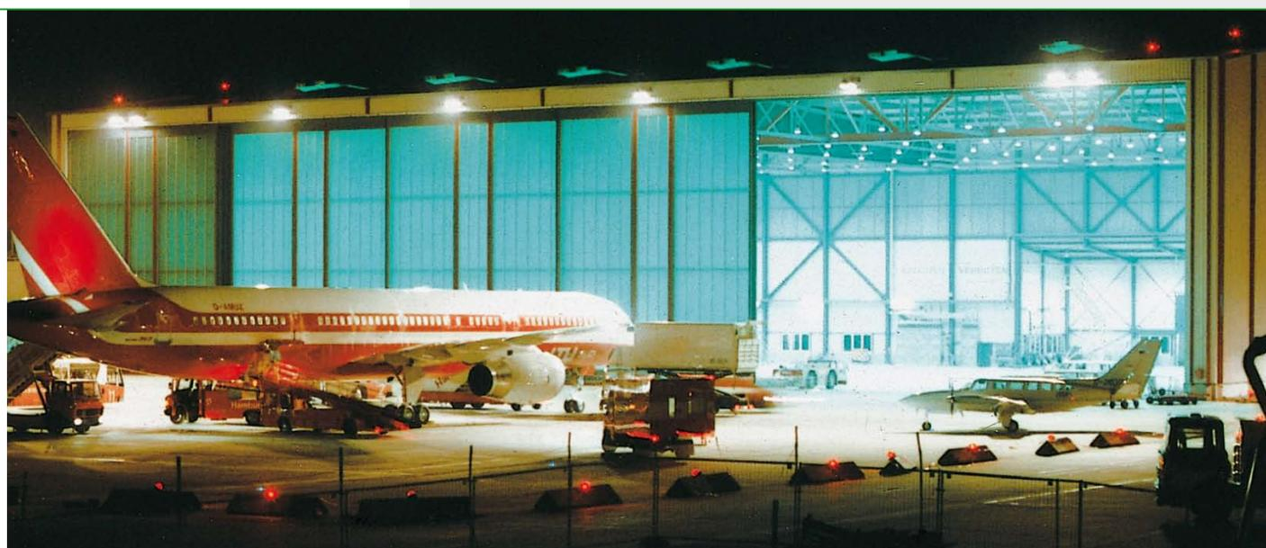
La structure alvéolaire des éléments de fibre de verre contribue à une très bonne isolation thermique et favorise l'utilisation passive de l'énergie solaire. Une étanchéité périphérique complète évite les déperditions d'énergie et la formation de courant d'air.
