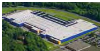
Hörmann KG Eckelhausen, Allemagne
